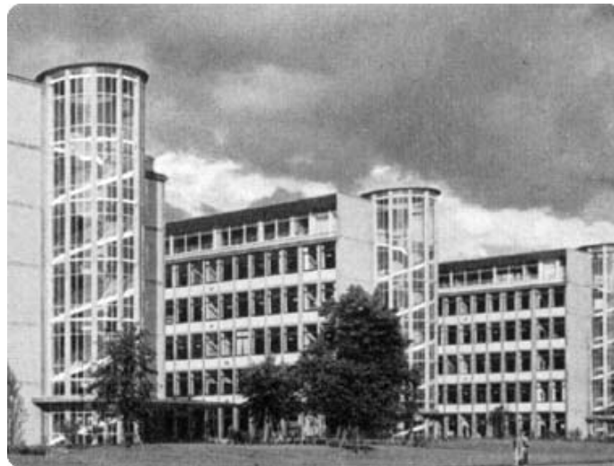
Abb. 5 Hochschule für Öffentliche Verwaltung im BBZ Doventorscontrescarpe 172
